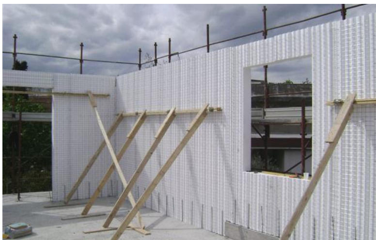
Figura B2 – Operazioni di allineamento dei pannelli.
