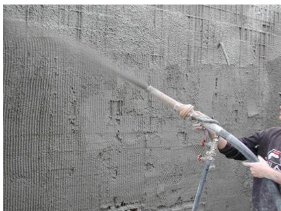
Figura B3 –Calcestruzzo applicato a spritz beton.
